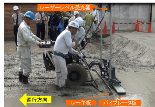
写真-2 スクリード機の現場試適用の状況
