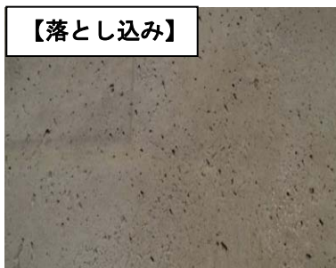
写真-3 打設方法の違いによる表面気泡の比較
