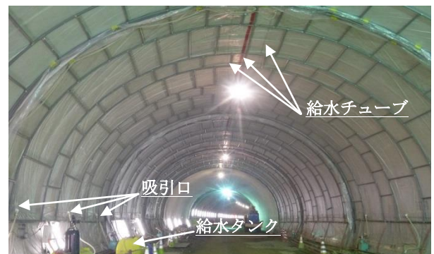
写真-1 本トンネルでの適用状況
