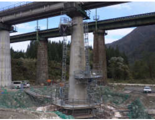
写真-1 昇降式足場
