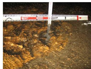
写真-2 インバートの洗掘状況
