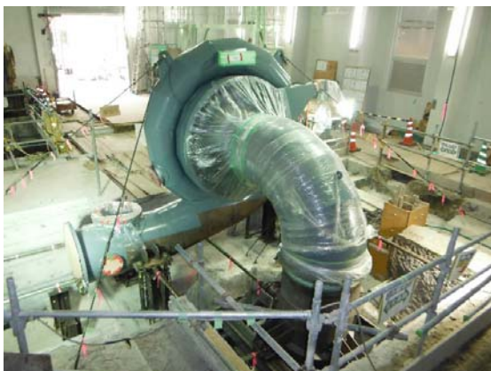
写真-3 ケーシング・吸出し管設置状況
