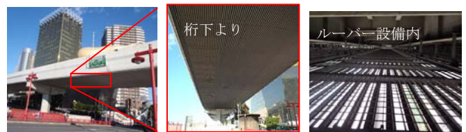
写真-1 美装化対象箇所の事例（ルーバー式）
