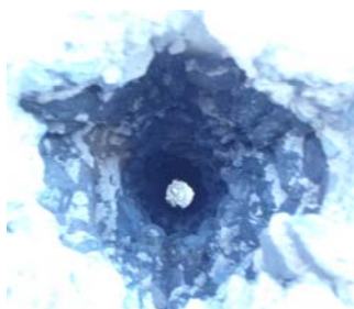
写真-5 削孔孔状況
