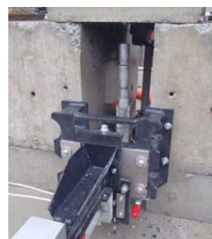
写真-3 削孔装置設置状況
