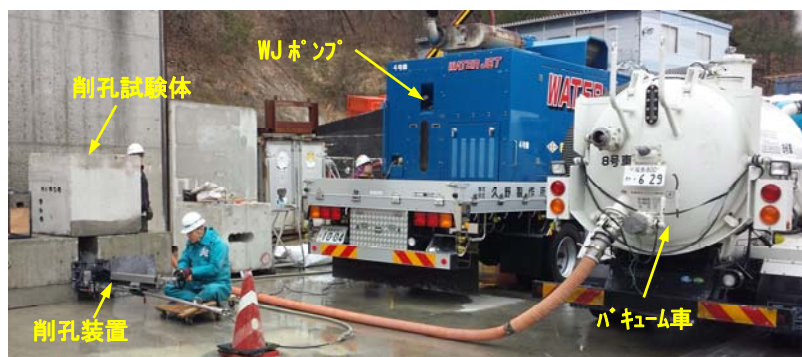
写真-4 削孔実験状況
