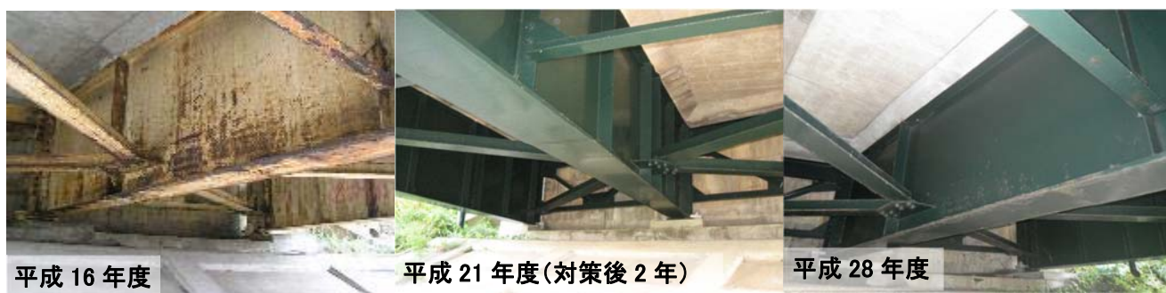
写真-1 個別橋梁の健全度の回復状況(鋼主桁)
