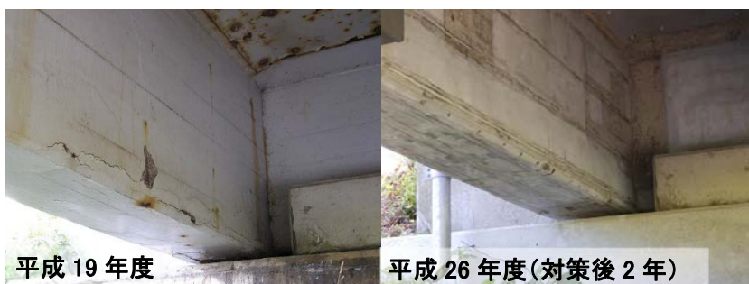
写真-2 個別橋梁の健全度の回復状況(コンクリート主桁)
