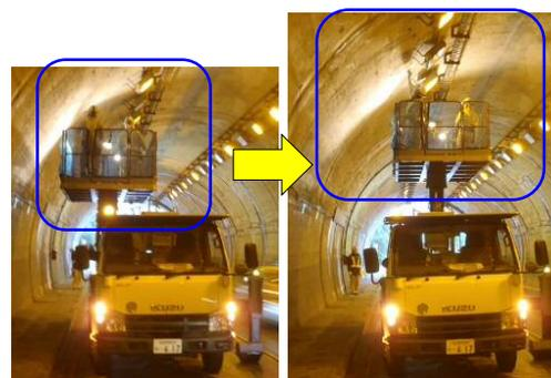
写真1 現行の点検作業におけるデッキの盛替え
