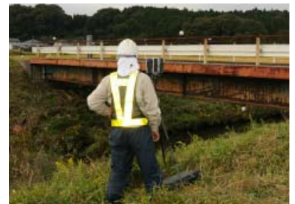
写真1：三次元スキャナー調査状況
