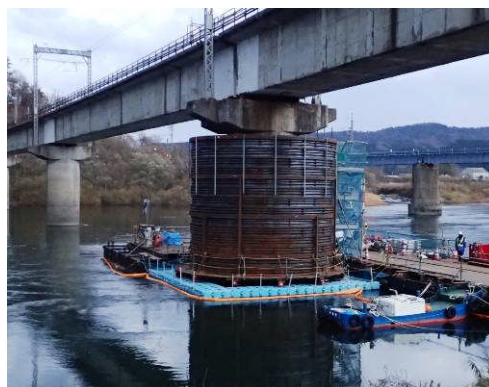
図-6 沈設前（組立完了）
