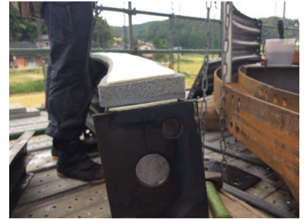
写真-2 3層の止水構造
