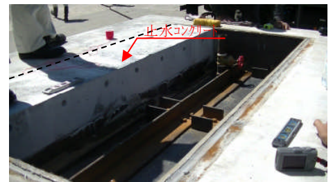
写真-3 加圧試験状況
