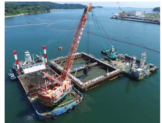
写真-1 P12の井筒内掘削状況
