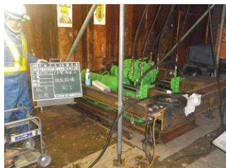
写真-13 鋼矢板壁面 盛土耐震補強工事
