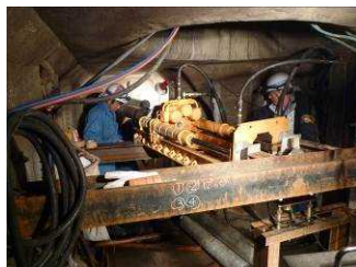
写真-8 支圧反力(後方)
