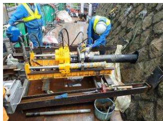
写真-12 コンクリート壁面 盛土耐震補強工事
