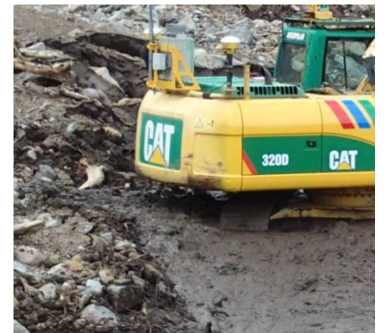
写真-1 泥濘化地盤での重機の沈み込み
