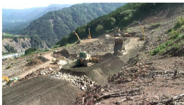
写真-2 土留盛土工の施工状況
