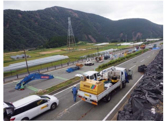
写真-1 1m 3 BH 分解状況
