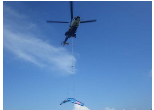
写真-2 1m 3 BH ブーム空輸状況
