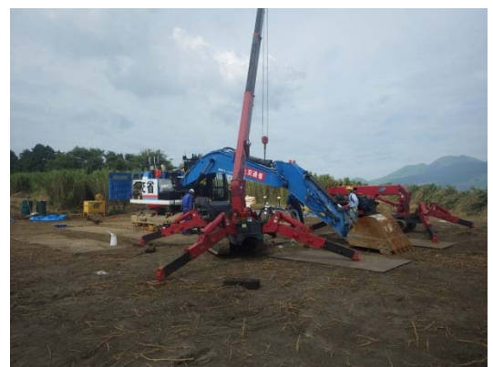
写真-4 カニクレーンによるアーム取付
