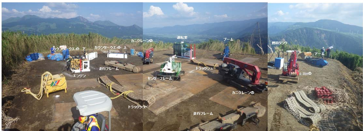
写真-3 1m 3 級バックホウとカニクレーン空輸完了状況
