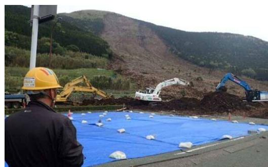
写真-3 マネジメント業務における遠隔機械操作
