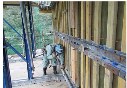
写真-4 型枠施工状況
