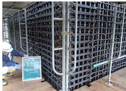
写真-3 鉄筋施工状況
