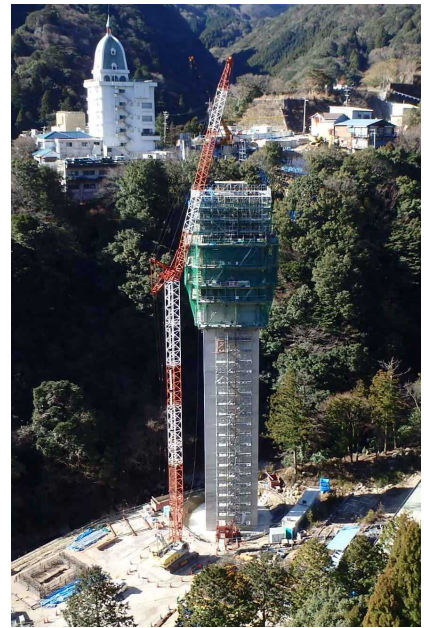
写真-1 施工状況
