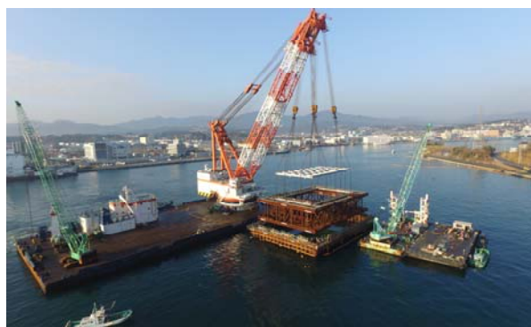
写真-1 トラス型支保工の設置状況
