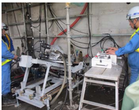
写真-1 製作機設置・削孔状況(1)
