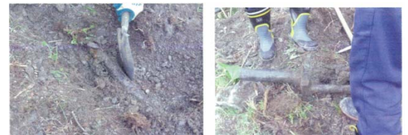
写真－1 試験体掘出し
