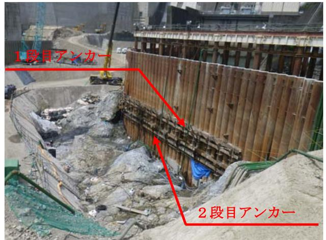
写真-1 グラウンドアンカーの完了全景
