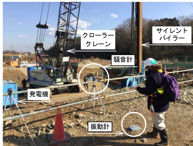
写真-1 クラッシュパイル工法と騒音・振動計測状況
