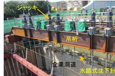
写真-1 吊り防護状況
