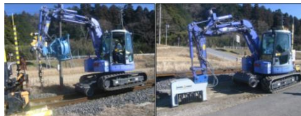
写真3. アタッチメント装着状況
