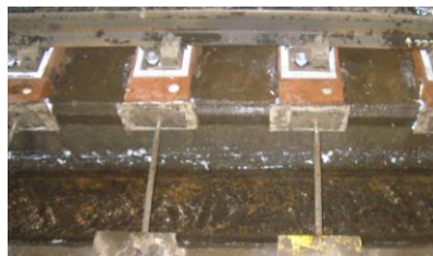
写真-2 パイプサポート取付状況
