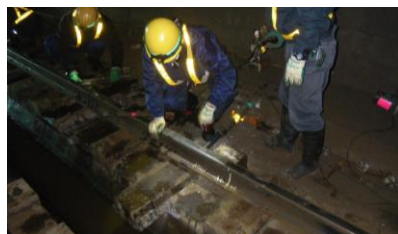
写真-1 まくらぎ押し抜き器使用状況
