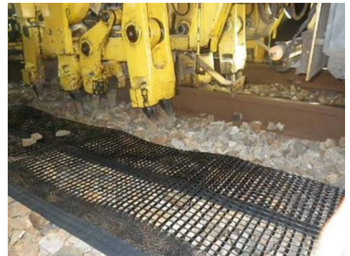
図3 MTT施工時の状況
