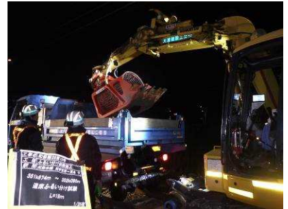
Fig. 3 ふるい分け施工状況
