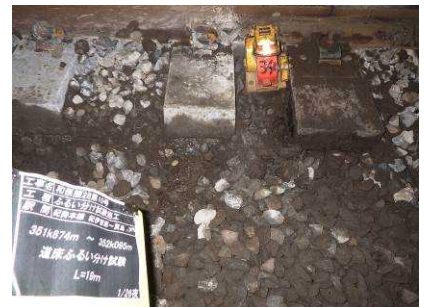
Fig. 4 掘削後排水状況一例
