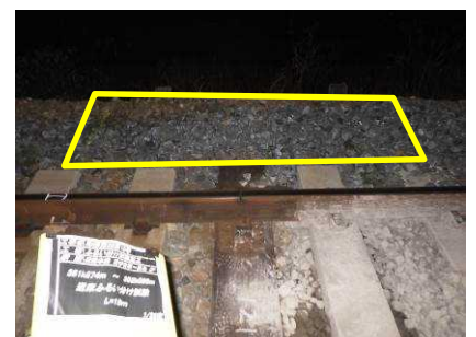
Fig. 2 施工箇所一例
