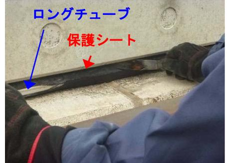
写真-1 保護シートの施工
