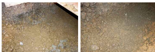
(a) 調査箇所 3-1 (保守多投入箇所)
