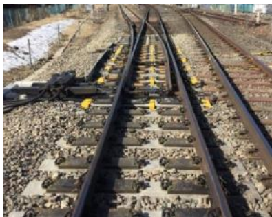
図1 地方幹線用 PC まくらぎ分岐器
