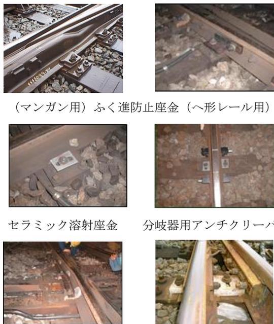
まくらぎ移動防止継材 樹脂製レール押さえ具
