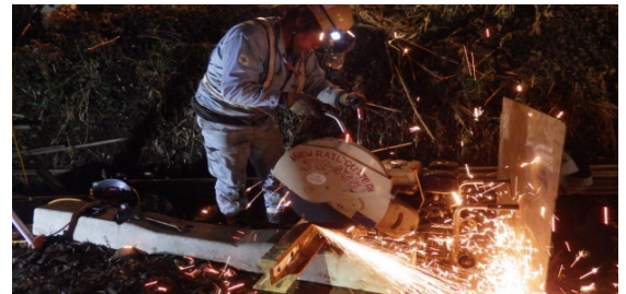
写真-1 切断状況(古 PC まくらぎに長ノズレール固定)
