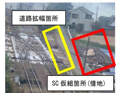
写真-2 交換箇所(切替前全景)
