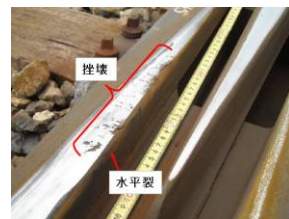
図2 踏面の外観(蓮田駅構内21号)
