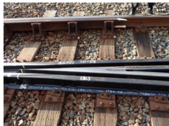
図1 レール製クロッシング
