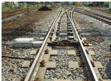
図1 2000 型分岐器
