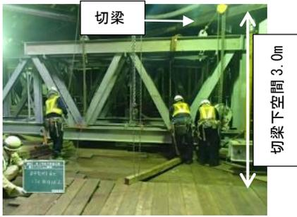
写真-1 トラスガーターの組立て状況
