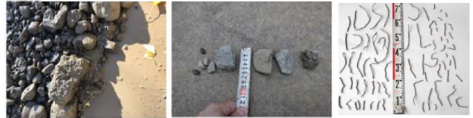
施工前の礫、栗石 排土後の礫、栗石 既設管鉄筋 写真-1 排土状況
