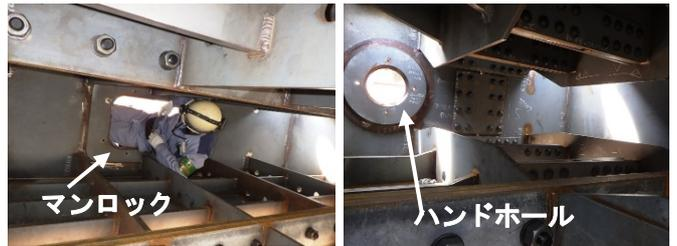
写真-2 鋼殻内部の施工開口
