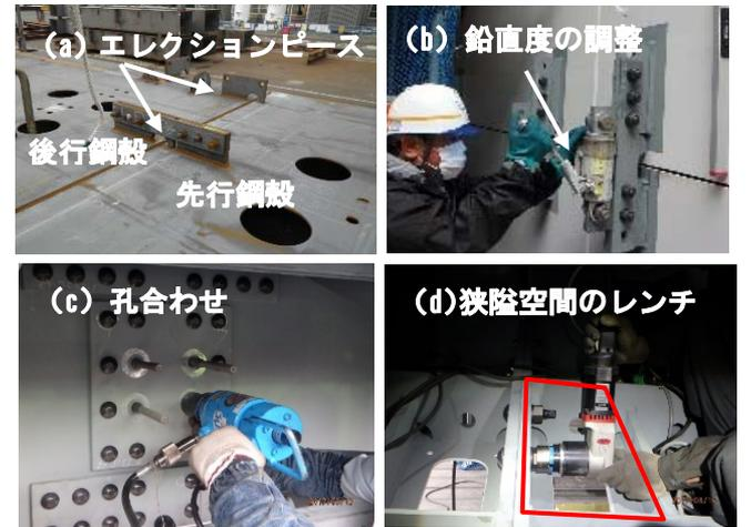
写真-4 組立精度を確保する工夫
