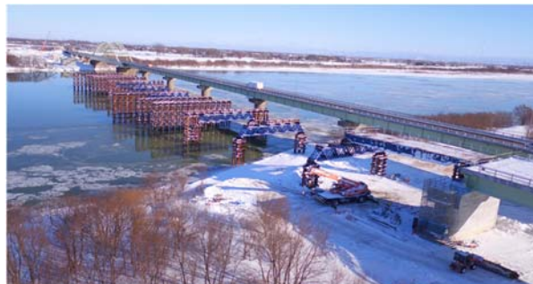
写-3 仮栈橋施工完了
