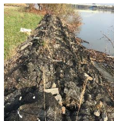
写-1 護岸ブロック及び袋型根固め工
