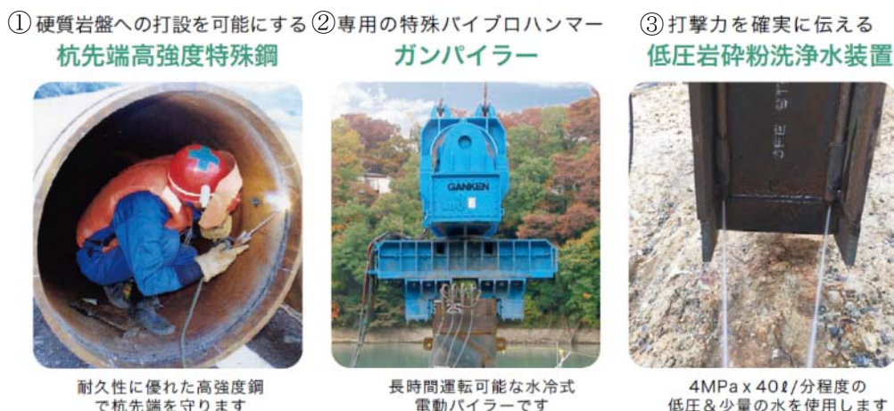
図-1 ガンパイル工法の主要3技術
