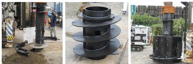
写真－3 治具口元管内収納式回転圧入方法
