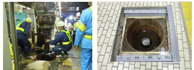
写真-2 仮覆工と鋼管杭打設状況
