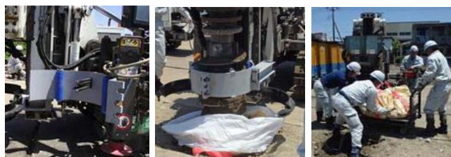
写真－7 土砂落とし装置と排土・回収作業
