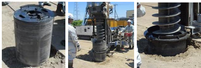
写真－4 治具口元管上乗せ式回転圧入方法
