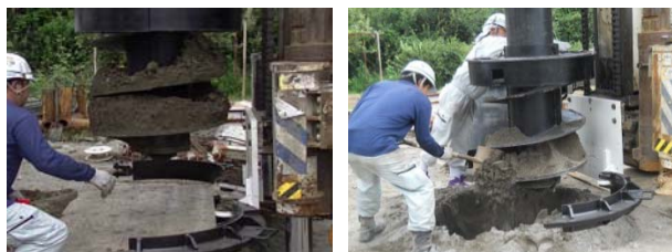
写真－6 人力土砂落とし
