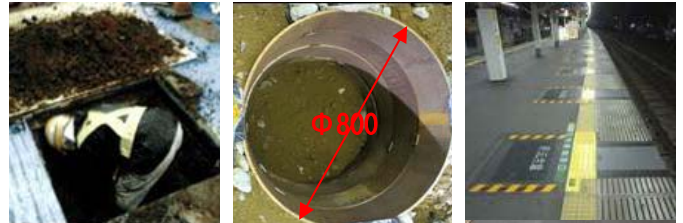
写真-1 人力掘削と口元管敷設状況
