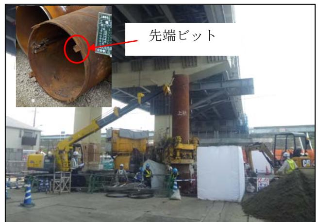
図3 鋼管杭圧入工 施工状況
