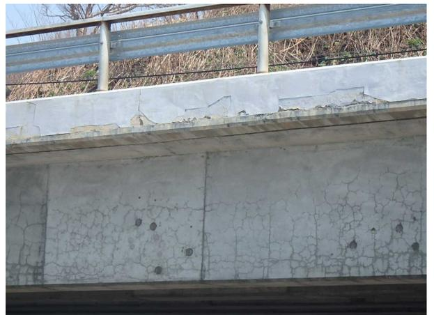
写真-1 損傷状況（最大ひび割れ幅 0.7 mm）
