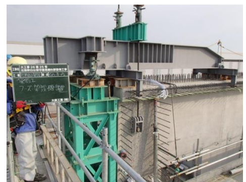
写真-1 セッティングビーム設置
