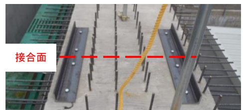
写真-2 接合部補強鋼材
