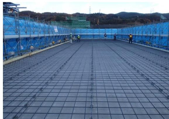
写真-6 配筋完了状況
