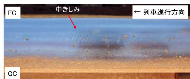
図2 中きしみ外観（調査箇所2）
