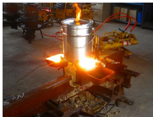
図 1 溶接試験状況
