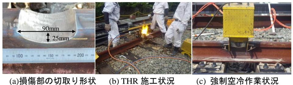
図 1 強制空冷による試験体作製状況
