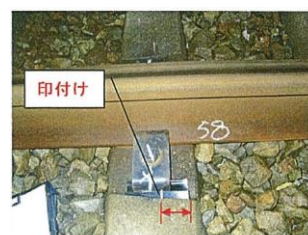
図-7 受台への計画線印付け
