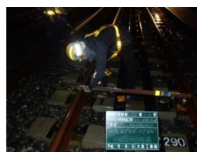
図-5 加工ゲージ使用状況
