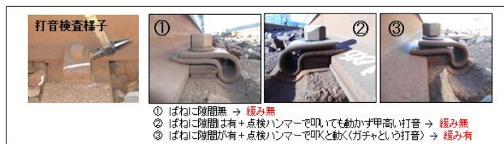
図-3 締結装置の緩み有無の検証（打音検査）
